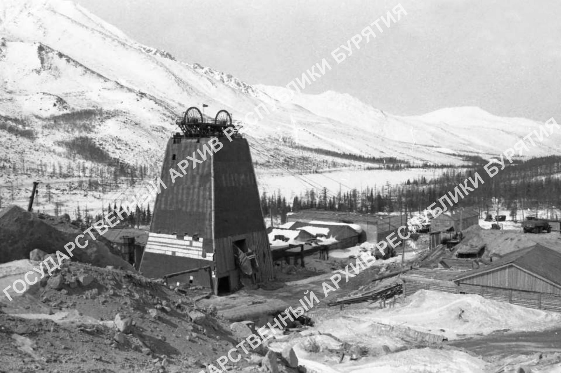
2-й ствол Северомуйского тоннеля. Автор А.М. Куртик. г. Северомуйск. 1979 г.
