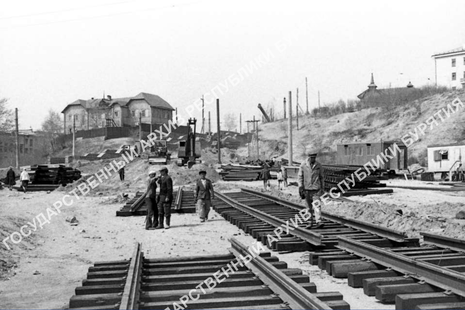
Строительство трамвайных путей. Автор А.М. Куртик. г. Улан-Удэ.
