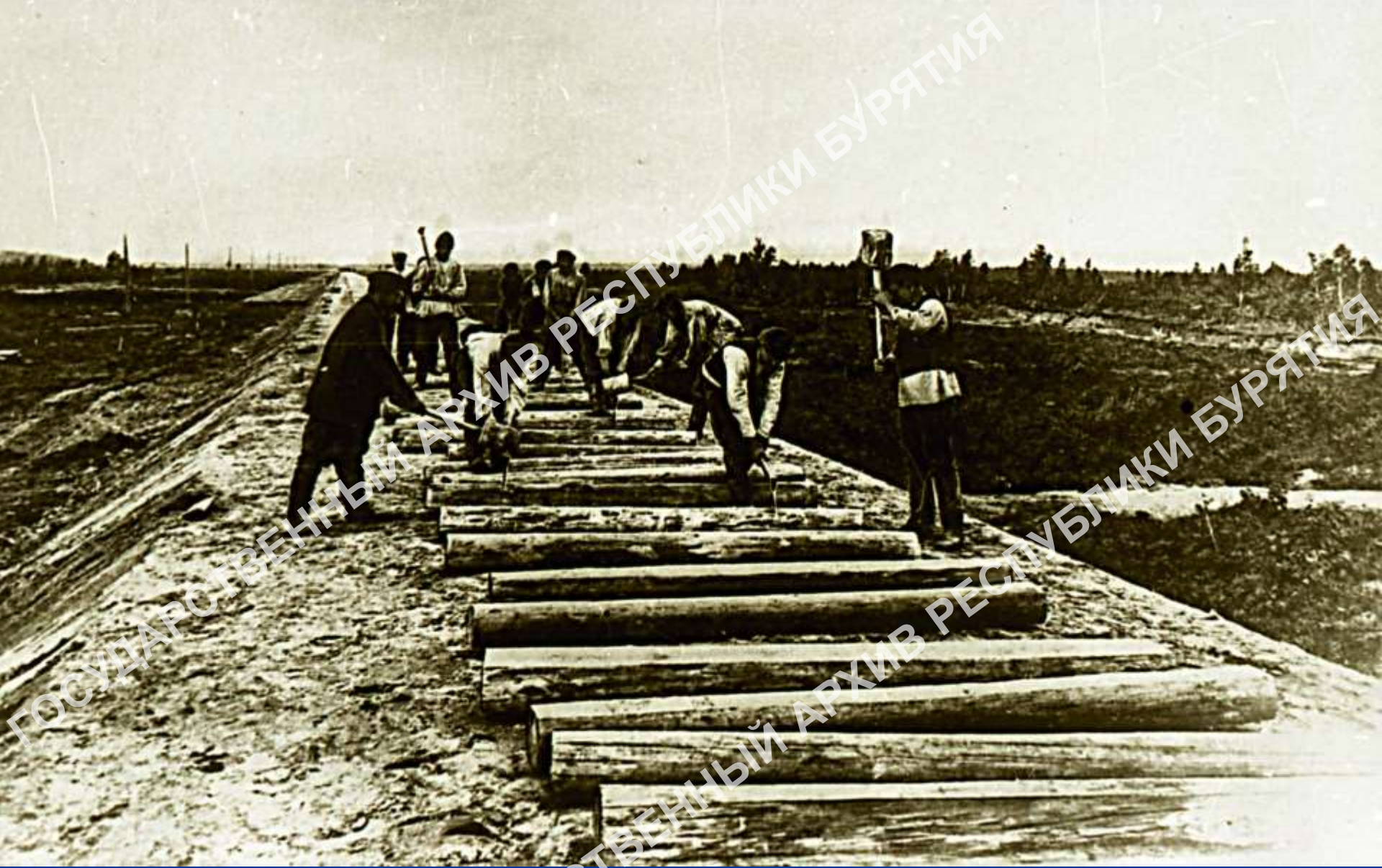
Строительство транссибирской железной дороги. 1892 г. Автор неизвестен. Репродукция А.М. Куртика ГАРБ. ФР. 1967. Оп. 1-н. Д. 476
