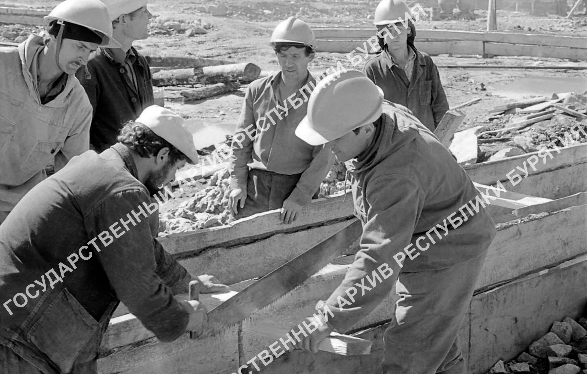
Байкальский тоннель. Даван. Бригада плотников В.Р. Толстоухова. Автор А.М. Куртик. Северо-Байкальский район. 1976 г. ГАРБ. ФР. 1967. Оп. 1-н. Д. 84
