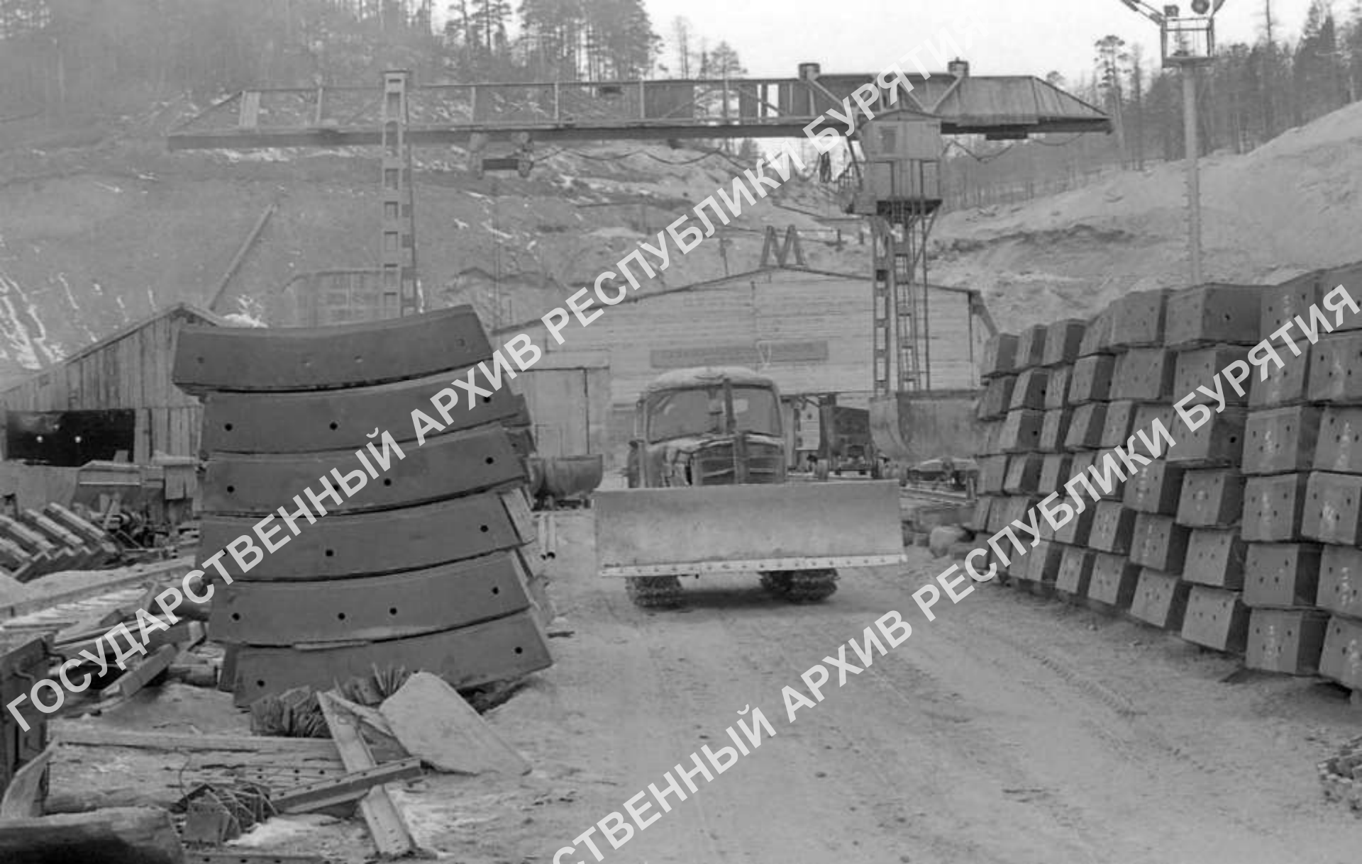
Восточный портал Северомуйского тоннеля. Автор А.М. Куртик. Северо-Байкальский район. 1979 г.
