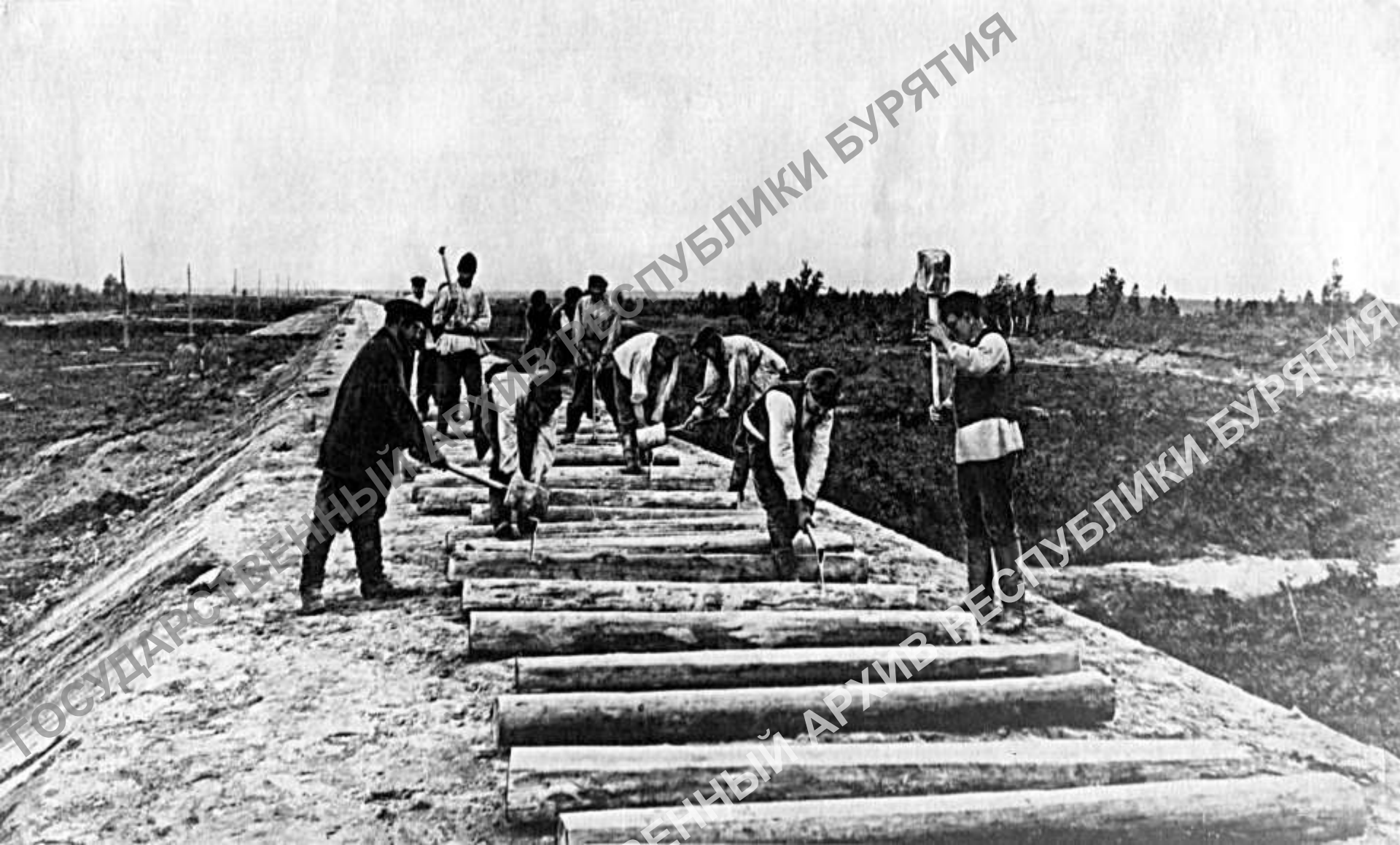
Укладка шпал рабочими Транссибирской железнодорожной магистрали. Июнь 1906 г. Автор неизвестен. Репродукция А.М. Куртика
